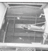
Korntanken med den lodrette snegl. Der er lidt rigeligt med klinkelkroge, hvilket kan give rengøringsproblemer i forbindelse med fremfald.
